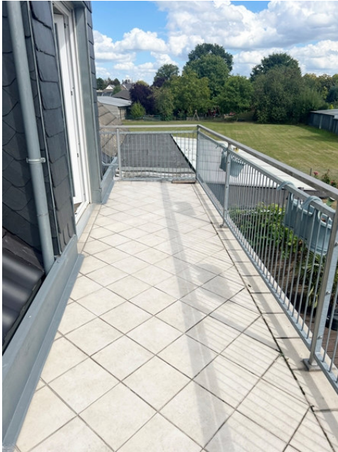
Balkon im OG
