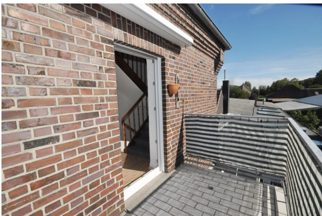
Balkon im OG
