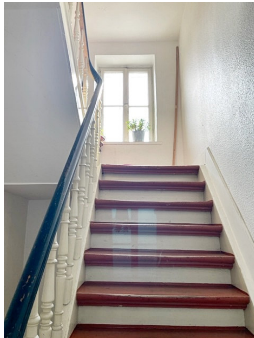
Treppenhaus zu den Wohneinheiten
