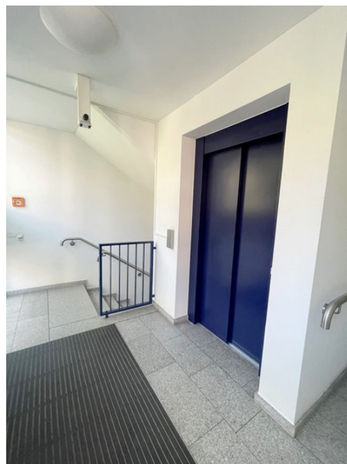
Treppenhaus u. Aufzug
