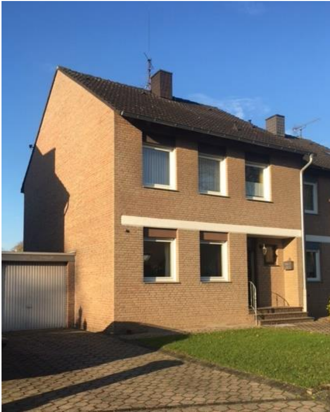
Hausansicht mit Garage
